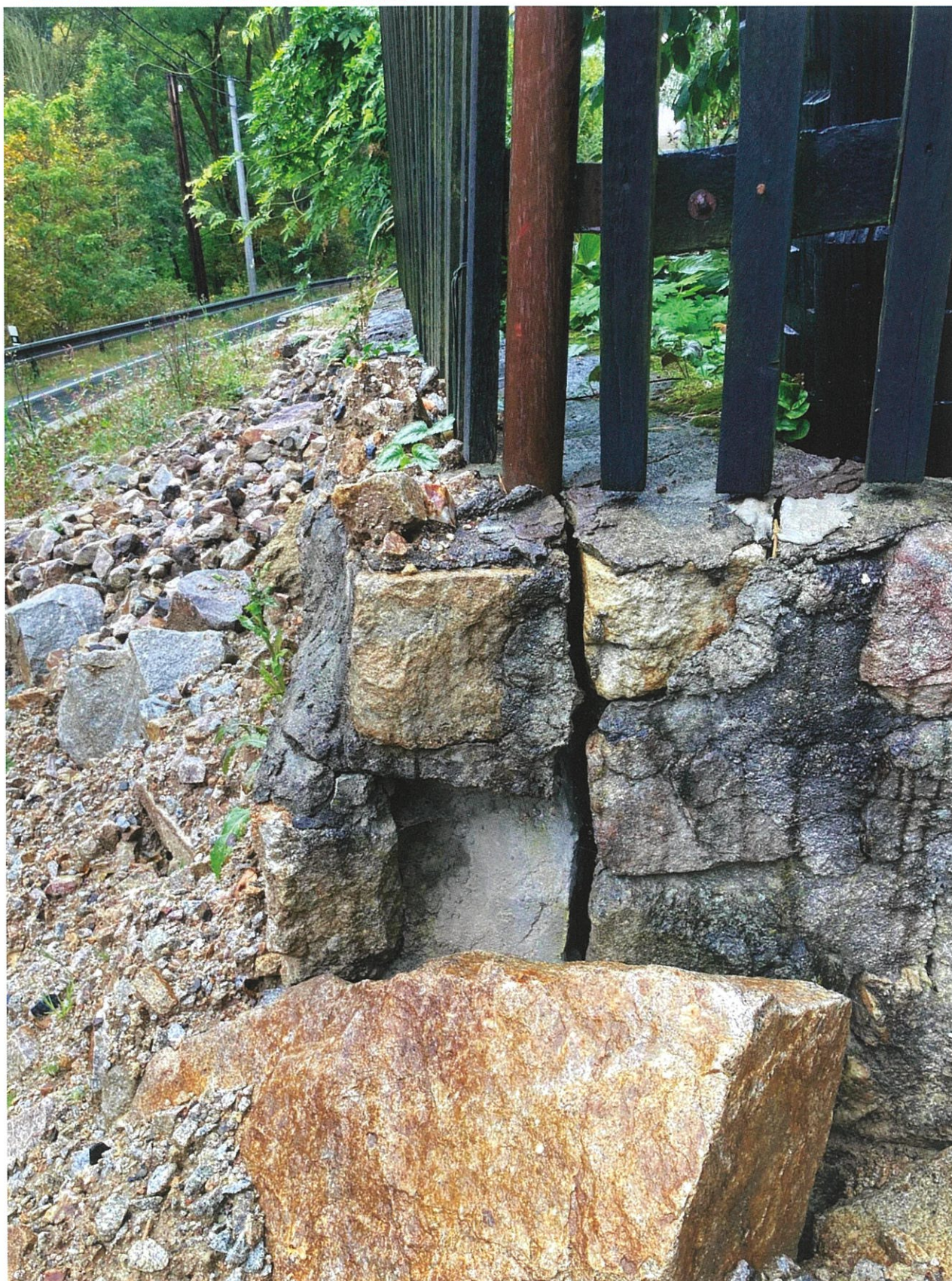
Pohled na pracovní spáru vzniklou vytrvalým posouváním, foto autor 5.10.2020
