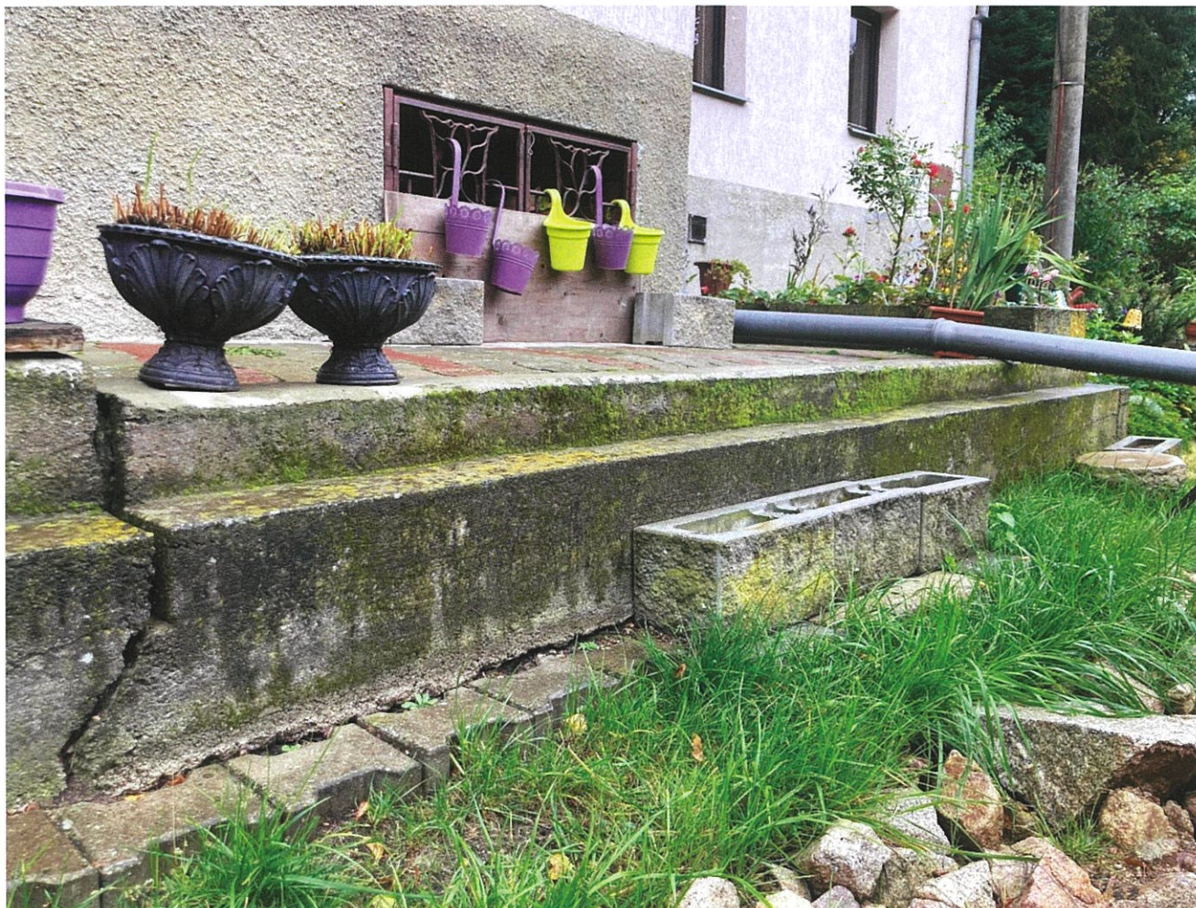
Pohled za rubovou stranu zdi, přistavěné pochozí plochy k rodinnému domu jsou deformovány jako důsledek plouživého vyklánění obkladní zdi, foto autor 5.10.2020
