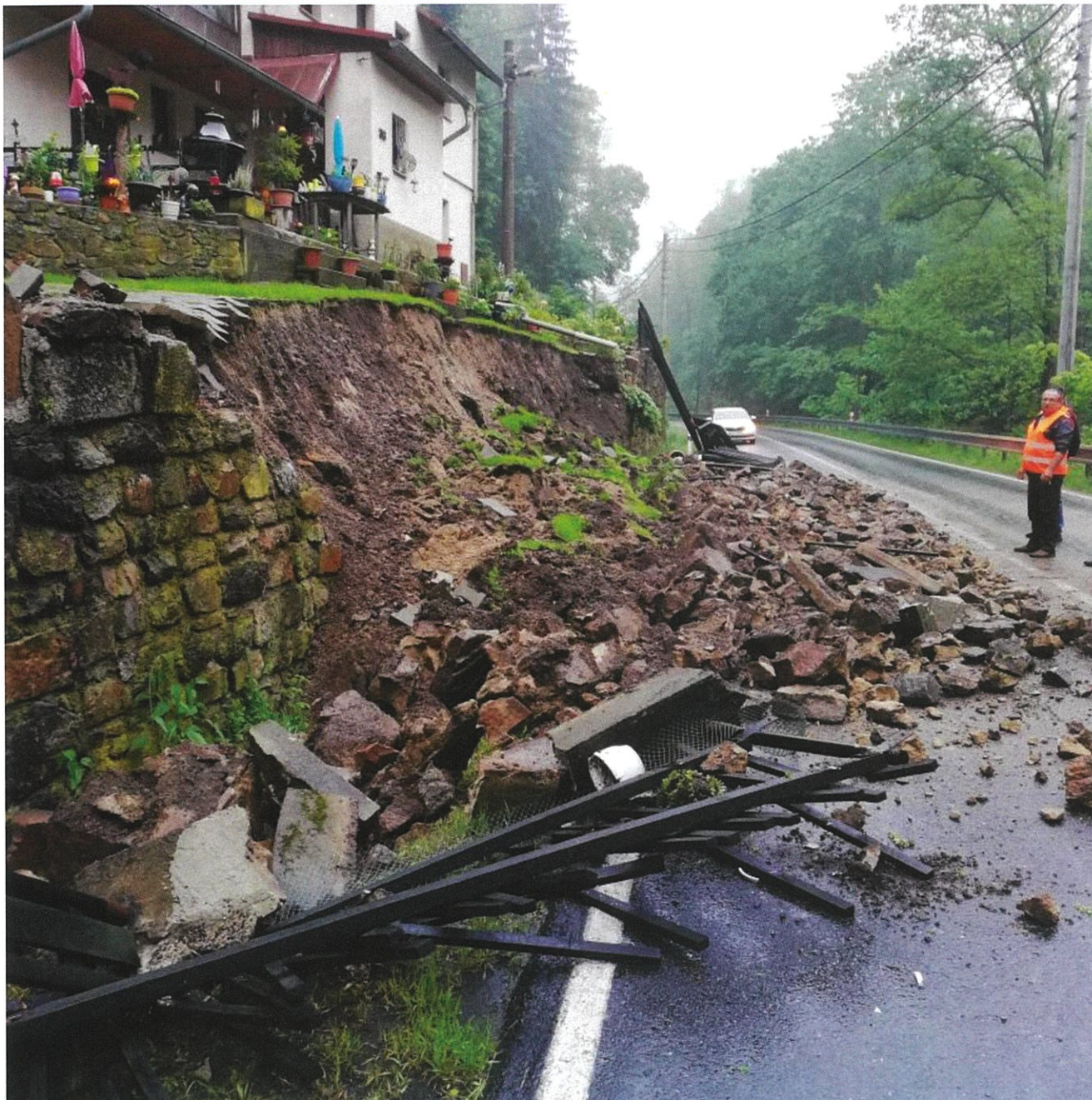
Stav 11.6.2020, odtrhová hrana kopíruje rubovou stranu obkladní zdi, uprostřed délky iniciační bod prolomení, foto zdroj KSÚSKK
